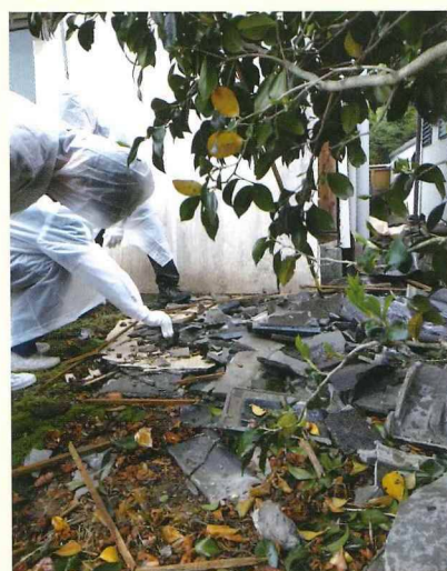
大津町瓦礫撤去
